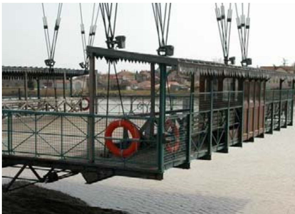
Nacelle du pont transbordeur de Rochefort-Martrou (17) Cl.CRMH Poitou-Charentes
